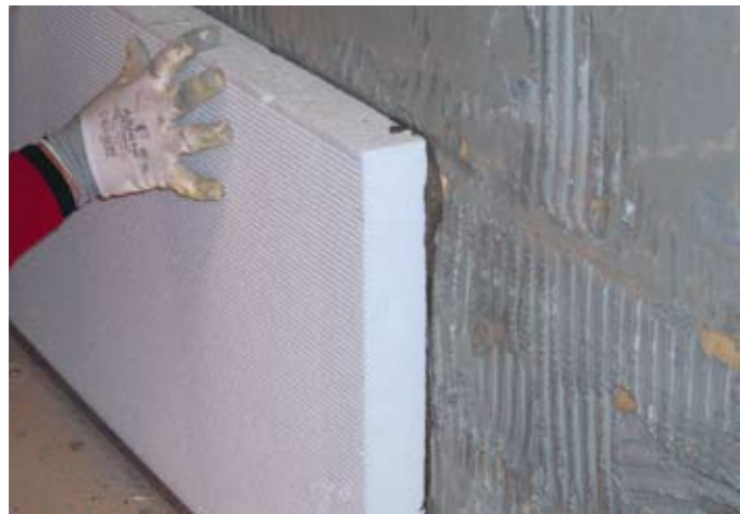
Incollaggio lastre isolanti ad adesione migliorata
