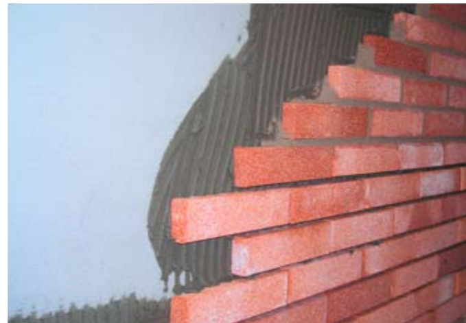
Posa listello facciavista UNIECO. Applicazione collante con spatola dentata da 1 cm, applicazione malta idrofugata su listello (perimetro), montaggio con tecnica "filo a piombo" o spessore di ferro.
