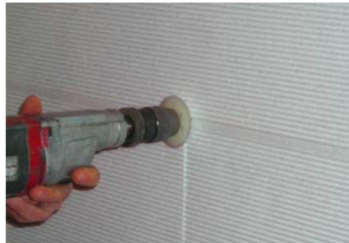
Tassellatura perimetrale e prima rasatura con rasante/collante mediante spatola dentata da 5 mm.
