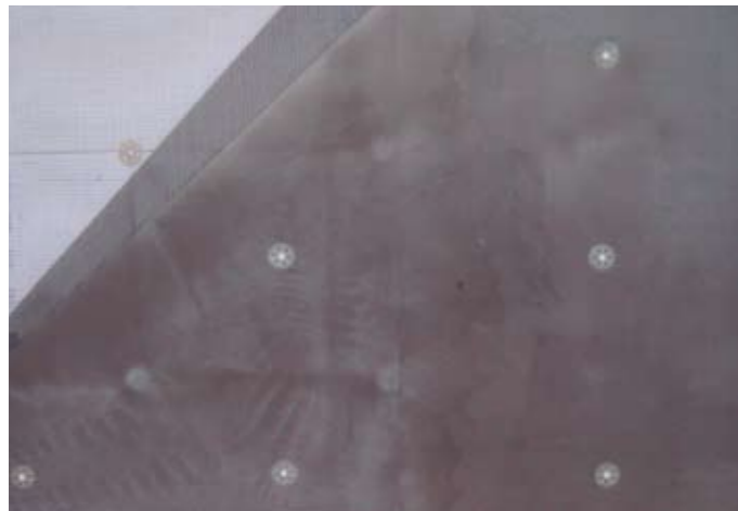
Seconda rasatura con rasante/collante/rete. Tassellatura centrale dopo 24 ore.
