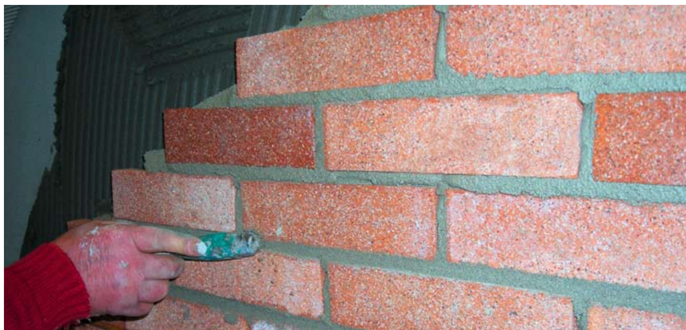
Posa listello facciavista UNIECO. Applicazione collante con spatola dentata da 1 cm, applicazione malta idrofugata su listello (perimetro), montaggio con tecnica "filo a piombo" o spessore di ferro.
